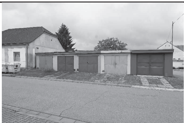
Stavba cizího vlastníka na pozemku
