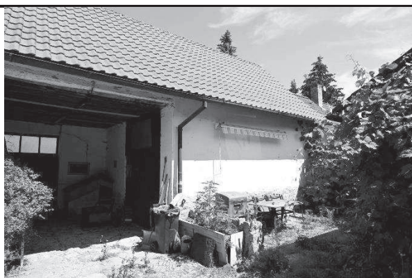
Pohled na průjezd a sklad
