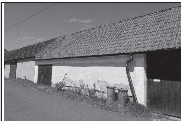
Pohled uliční část domu
