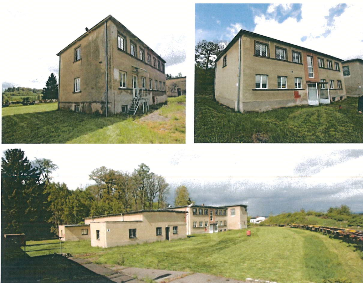
Obrázek 11: Fotodokumentace staveb – sklad a bývalá ubytovací budova štábu
