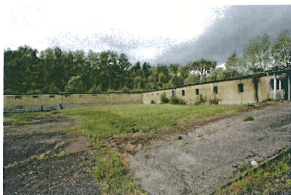
Obrázek 10: Fotodokumentace staveb – skladová a servisní budova
