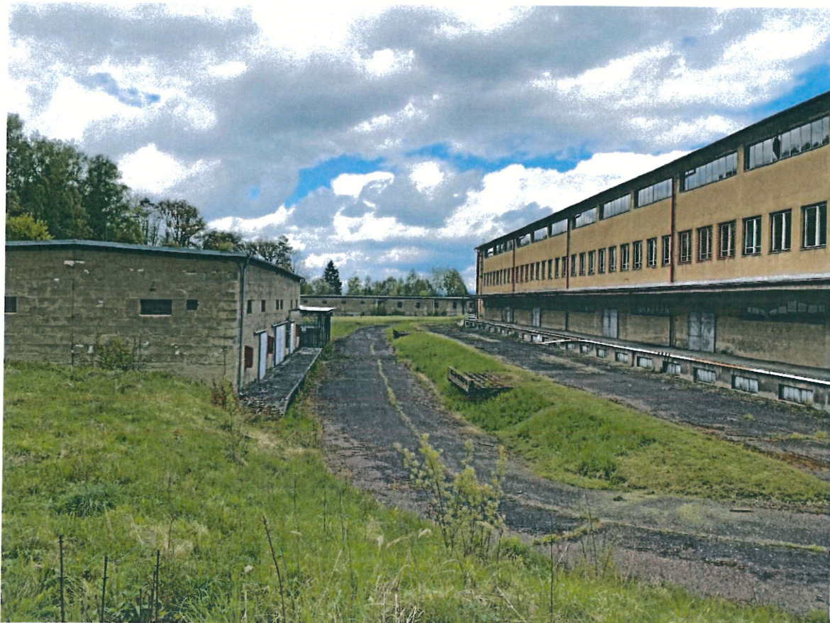
Obrázek 4: Fotodokumentace části oceňované nemovitosti
