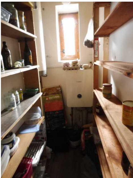
Technická místnost s elektrokotlem a bojlerem
