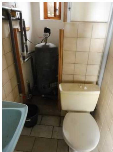
WC s vodárnou
