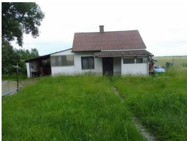
Vedlejší stavba – dílna s přistavěnou terasou
