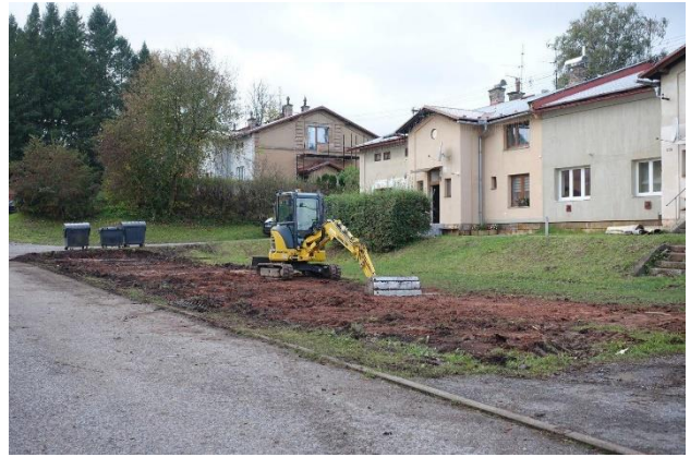
P.p.č. 213/5 po demolicí kůlen
