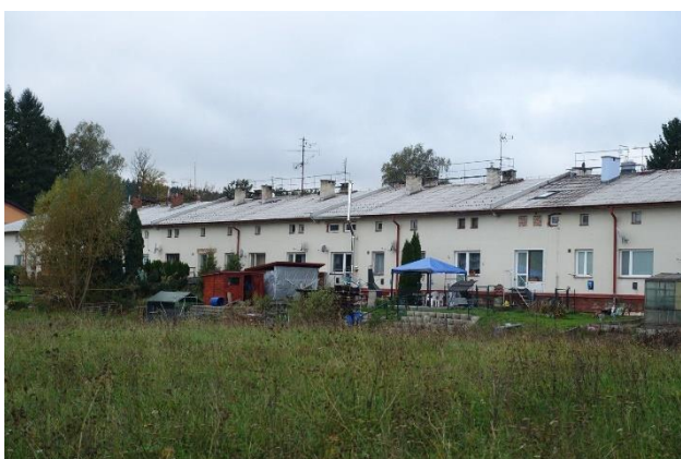
JV průčelí domu
