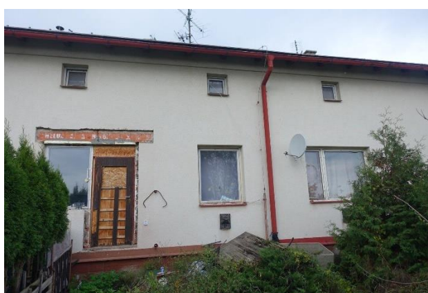
JV průčelí domu
