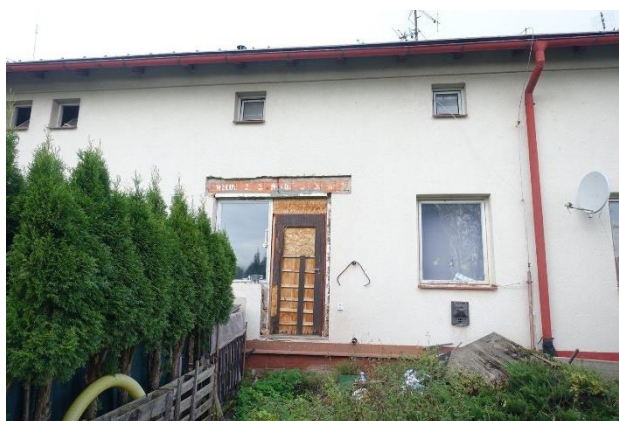
JV průčelí domu
