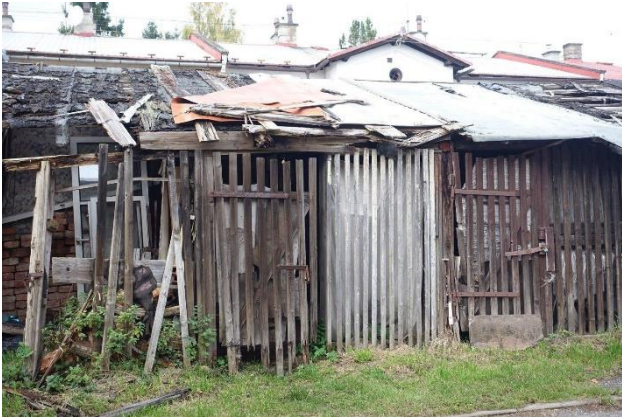
Kůlny před demolicí na p.p.č. 213/7
