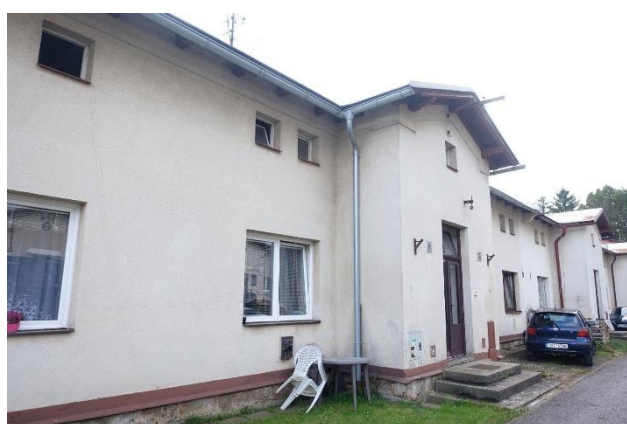
SZ průčelí domu
