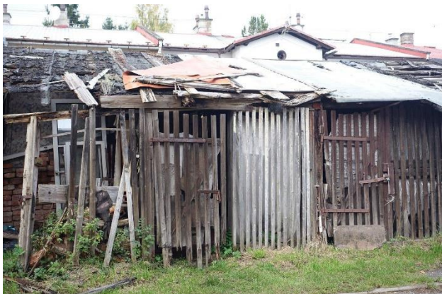
Dožité dřevníky na st.p.č. 213/7, již jsou odstraněny
