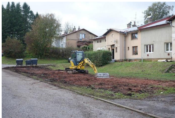
St.p.č.213/5 po demolici dřevníků
