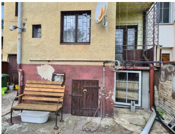
Fotodokumentace předložená spoluvlastníkem
