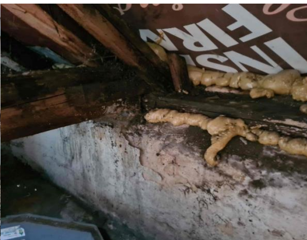
Fotodokumentace předložená spoluvlastníkem
