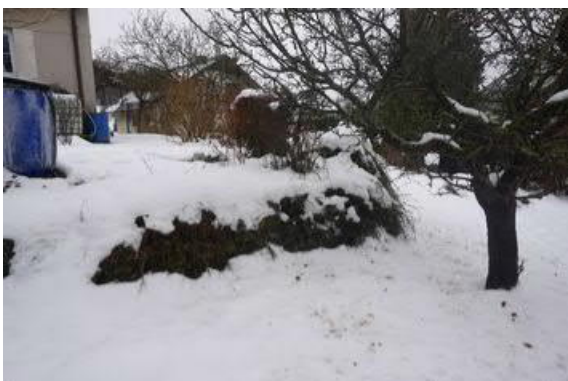
vyvýšená část septiku
