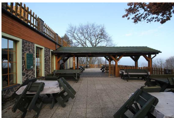
Terasa se zastřešením bočního vstupu
