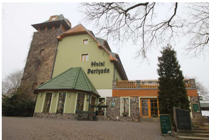
Celkový pohled od příjezdu (vlevo přízemní hlavní vstup do objektu)
